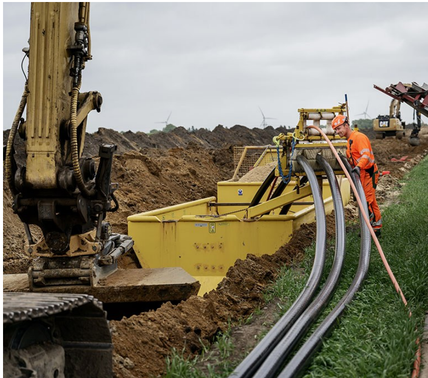
Nedgravning af kabler i Vestjylland.
